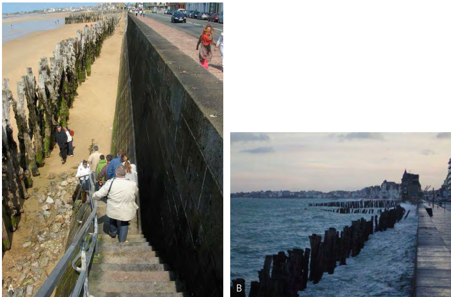
Figure 2-98. Digue de Saint-Malo : perré, parapet et pieux « brise-lames » à marée basse et lors d'une marée haute de fort coefficient (106) (Sources : A) R. Tourment ; B) Larzaliier, Wikipedia).
