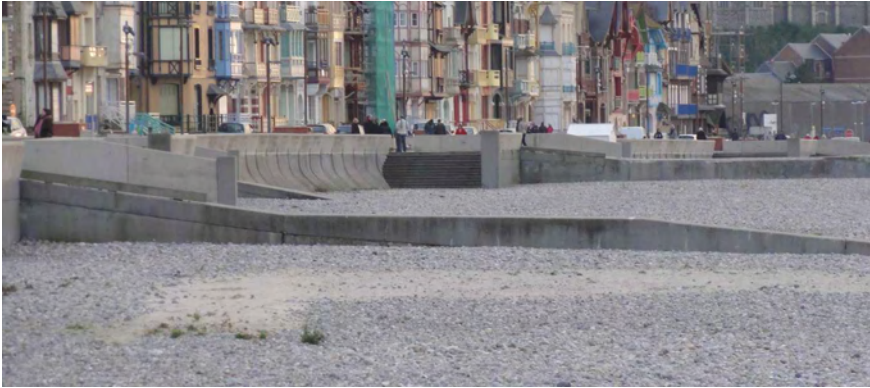
Figure 2-101. Mur chasse-mer et épi, à Mers-les-Bains dans la Somme (Source : C. Caffin, DREAL Hauts-de-France).
