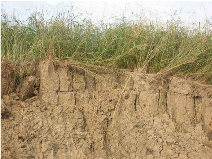
Figure 2-27. Sol fissuré en profondeur (Source : R. Tourment).
