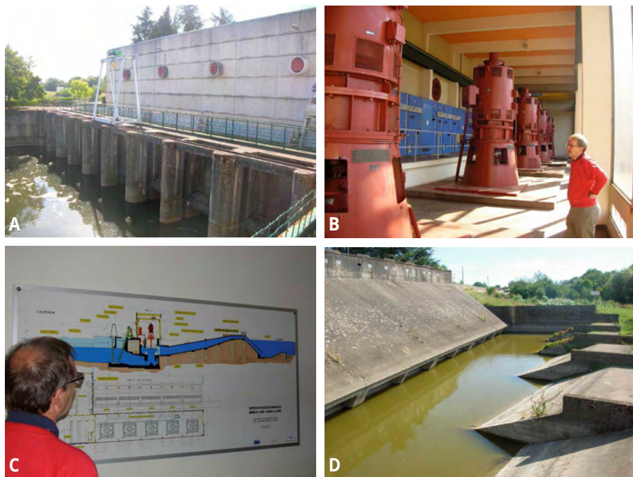
Figure 2-94. Station de pompage de l'Authion (Source : R. Tourment). A) Amont (rivière Authion). B) Salle des pompes. C) Coupe de la station. D) Ouvrage de restitution aval (côté Loire).
