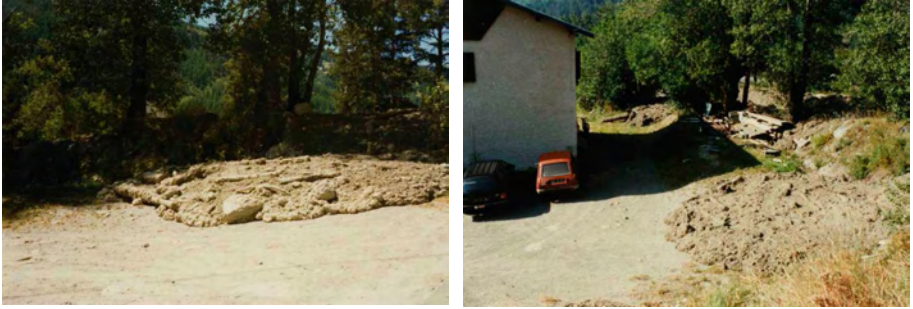
Figure 5-71. Surverse d'une bouffée de lave sur la digue rive gauche : torrent du Verdarel, crue de 1988 (Source : fonds ONF - RTM 05).
