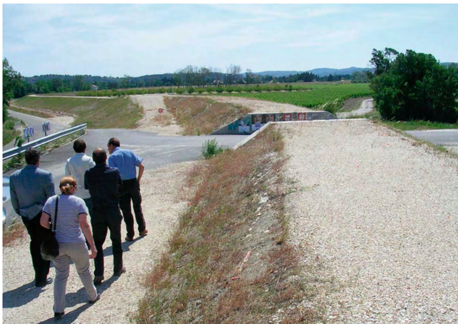
Figure 2-91. Passage routier batardable à travers une digue (à droite) et rampe d'accès à la piste de service en crête (à gauche) (Source : R. Tourment).
