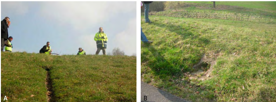
Figure 5-41. Exutoire sur le talus côté ZP d'une digue (A) d'un collecteur des eaux pluviales de la chaussée, situé en crête (B) (Source : R. Tourment).
