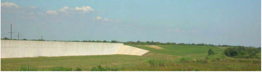
Figure 2-80. Mur autostable en T en béton armé et transition avec une digue en remblai, partie du système de défense anti-ouragans de la Nouvelle Orléans (Source : R. Tourment).
