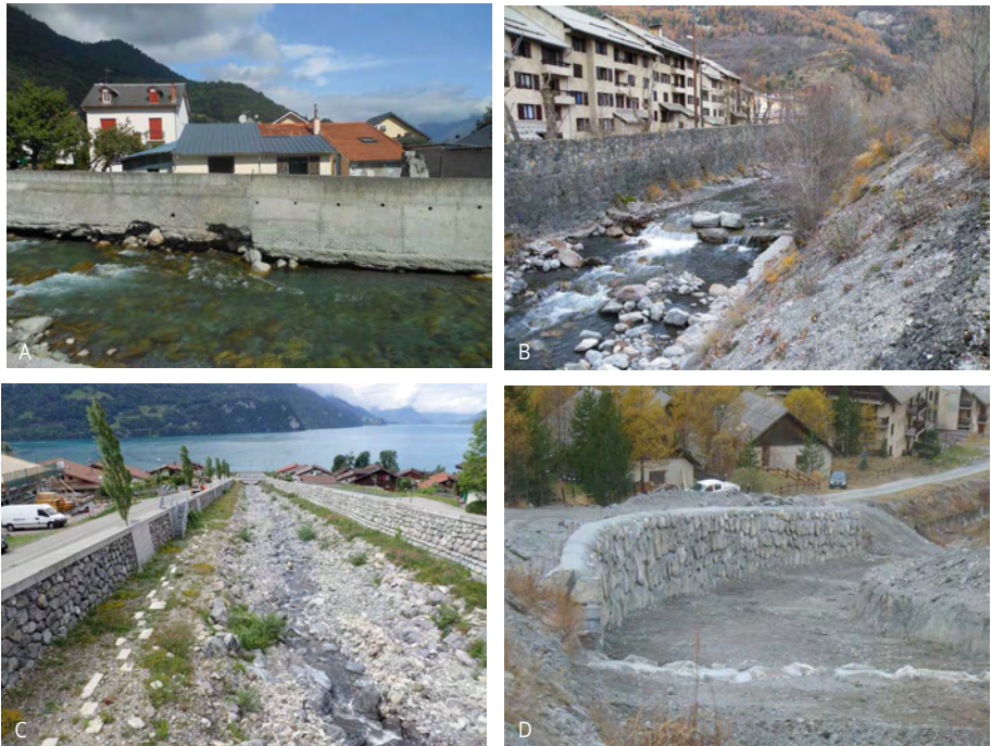
Figure 2-105. Exemples d'ouvrages rigides (Source : ONF – RTM 05).
