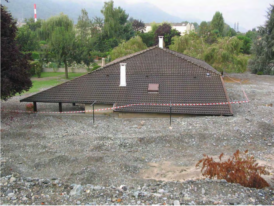
Figure 5-73. Maison engravée en rive gauche du Doménon, crue du 22-23 août 2005 (Source : ONF - RTM 38).
