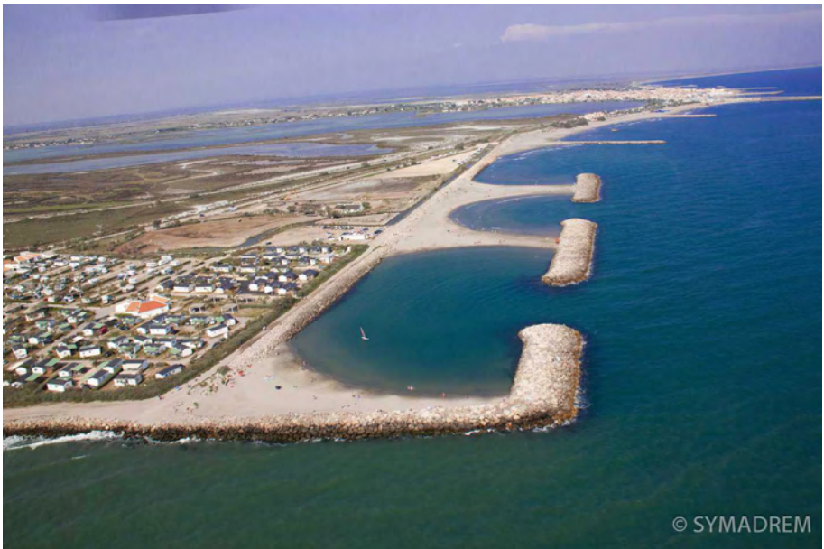
Figure 2-100. Brise-lames et épis protégeant une digue côtière à l'embouchure du Petit Rhône (Source : Symadrem [9]).
