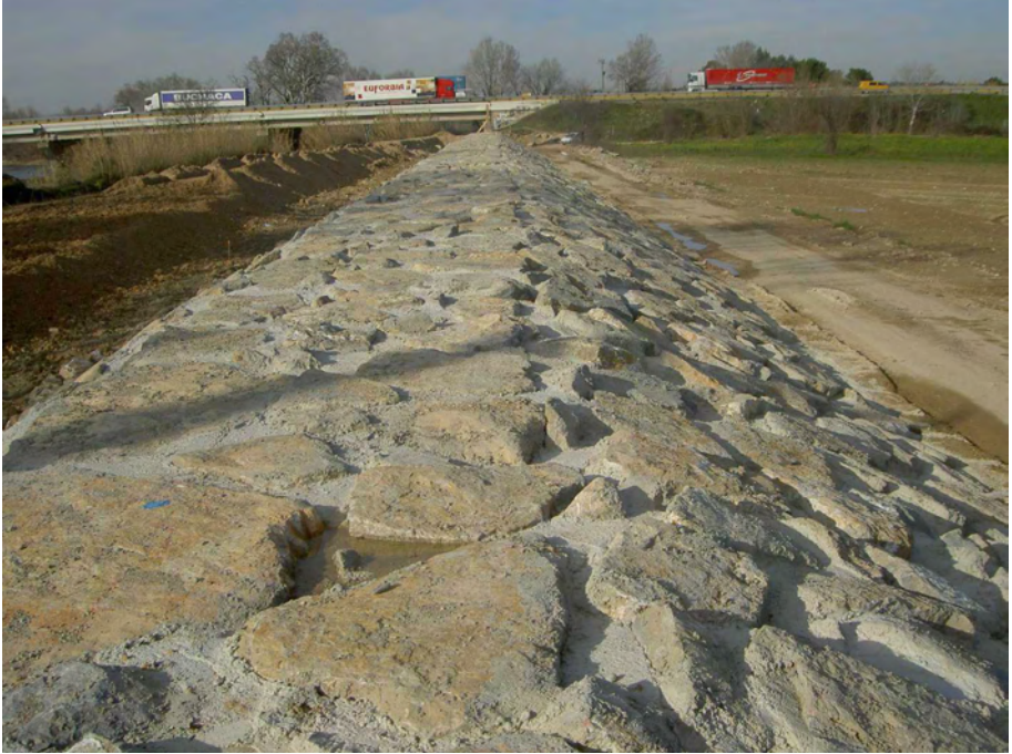
Figure 2-85. Digue en remblai caparaçonnée sur le Vidourle, en fin de chantier (Source : G. Degoutte).
