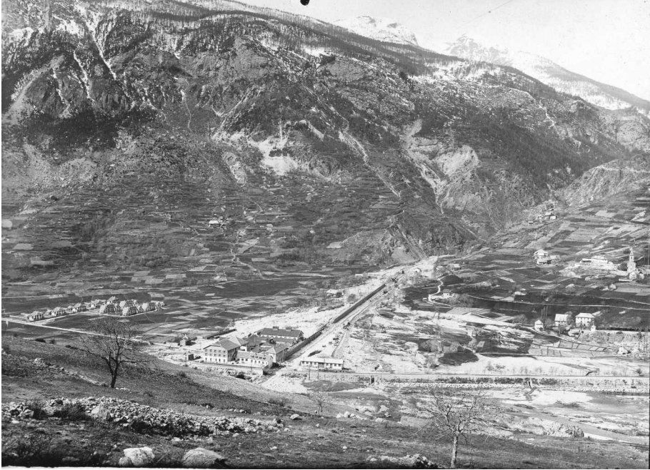
Figure 5-61. Vue des brèches sur l'endiguement du Fournel après la crue de 1928 (Source : M. Henry, fonds ONF – RTM 05).
