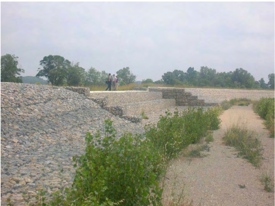
Figure 2-87. Déversoir sur le Vidourle (Source : B. Beullac). Ce déversoir, protégé de l'érosion par des gabions, comprend deux niveaux de déversement. Le niveau primaire (au centre de la photo) est en gradins, le niveau secondaire a une pente régulière ; la section de digue non déversante n'est pas visible sur la photo.
