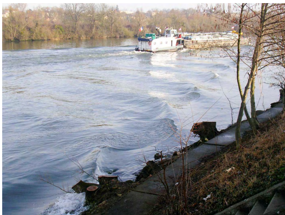
Figure 5-46. Batillage dû à la navigation sur les digues de l'île des Impressionnistes (Croissy-sur-Seine) (Source : R. Tourment).
