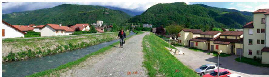
Figure 2-32. Lit perché sur son cône – Digue du Doménon (Source : R. Tourment).
