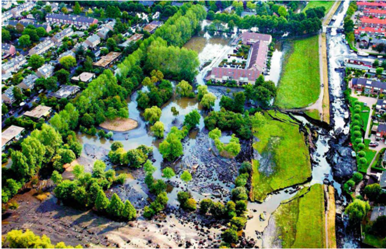
Figure 2-25. Glissement translationnel ayant affecté un corps de digue en terre sur fondation vasarde (Source : STOWA [9]).
