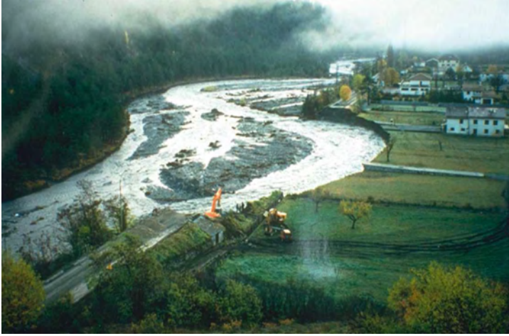
Figure 5-69. Large brèche par érosion latérale liée à la divagation du lit : crue du Var de 1994 – Commune de Guillaumes (06) (Source : RTM 06).
