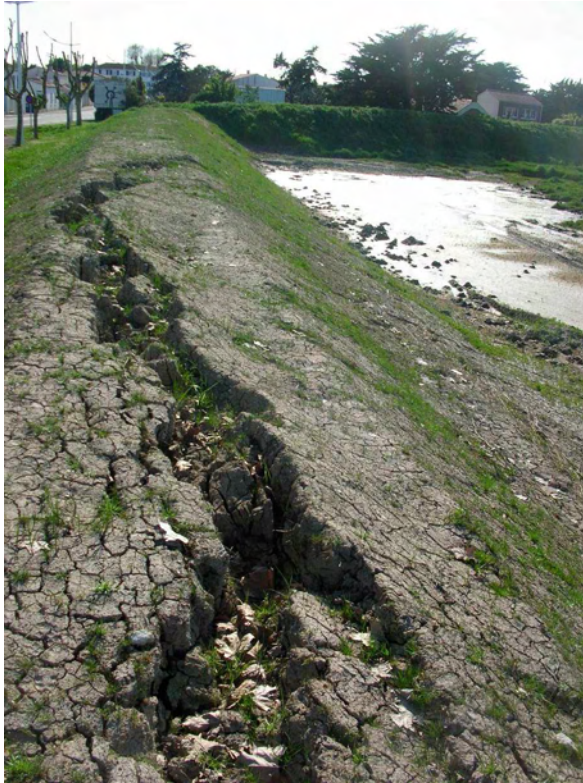
Figure 2-23. Glissement rotationnel d'un corps de digue en terre à la suite d'une mise en œuvre à une teneur en eau excessive (Source : R. Tourment).
