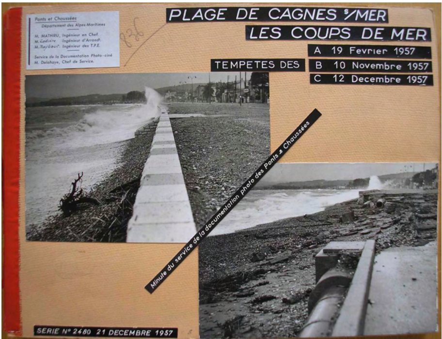
Figure 8-3. Destruction partielle du mur de protection en arrière de la plage de Cagnes-sur-Mer (Source : Archives départementales des Alpes Maritimes, rapport de visite de terrain des Ponts-et-Chaussées, 1957).
