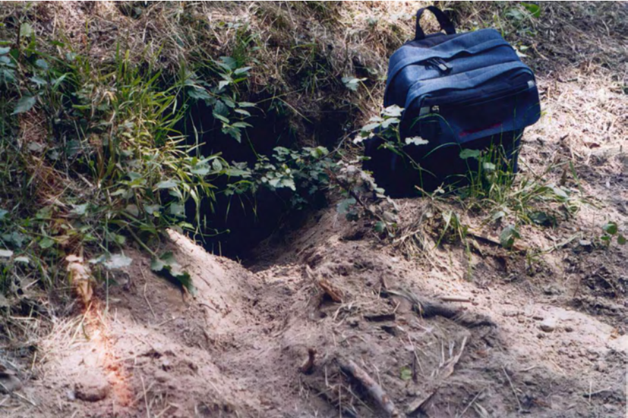
Figure 5-48. Terrier de blaireau sur une digue (échelle : la largeur du sac est supérieure à 30 cm) (Source : R. Tourment).
