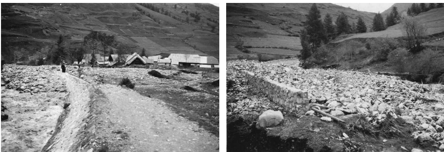
Figure 5-70. Surverse sur la digue RD à la suite de l'engravement total du lit par charriage : torrent du Chagnon (Vars 05) – 1957 (Source : fonds ONF – RTM 05).
