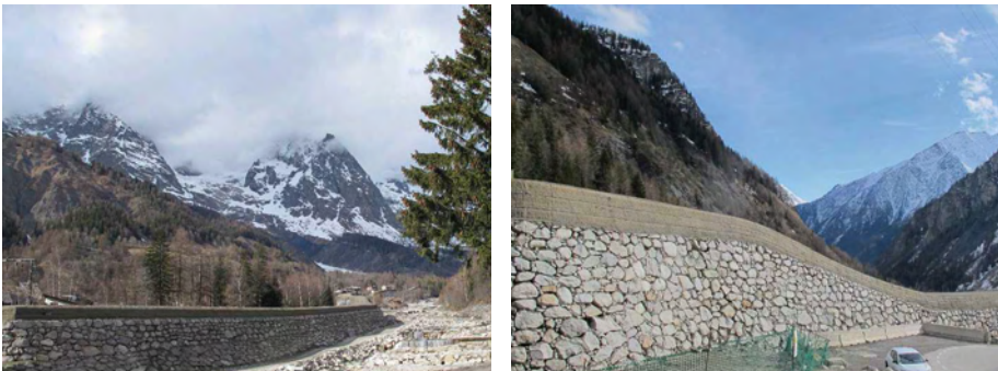
Figure 2-34. Digue de la Palud à Courmayeur (Val d'Aoste - Italie) (Source : P. Bouvet, ONF - RTM 05).
