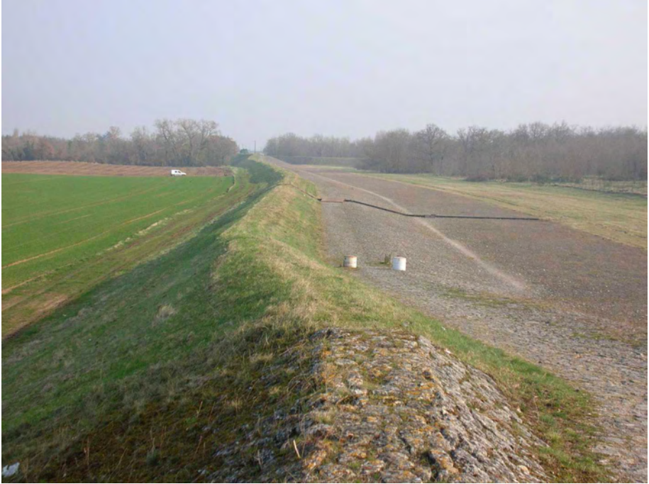
Figure 2-88. Déversoir de Jargeau (Val-d'Orléans, 45) (Source : R. Tourment).
