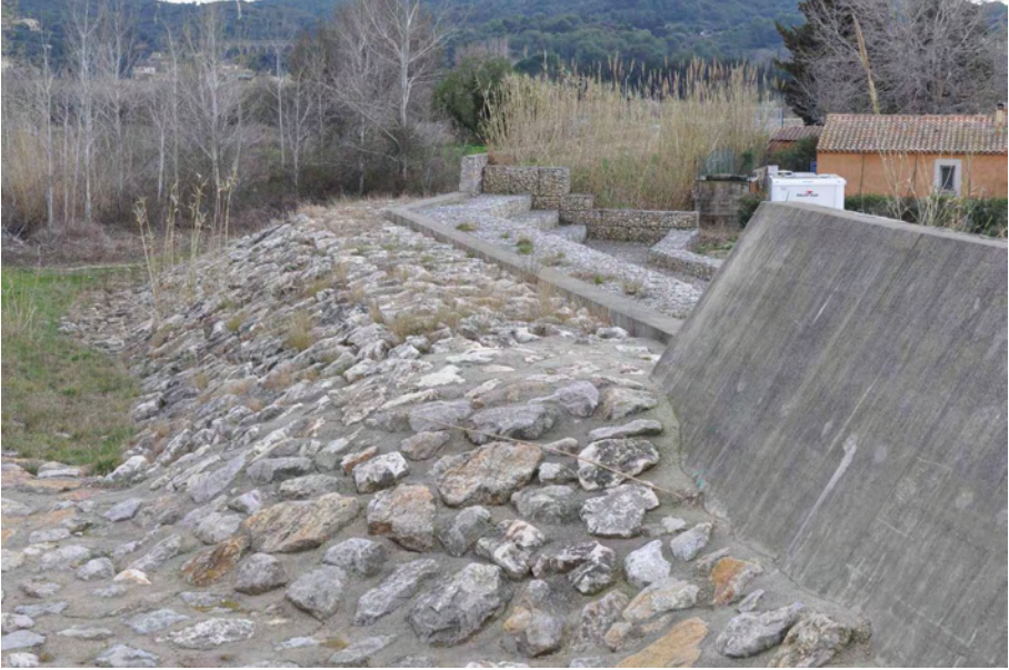
Figure 2-86. Déversoir de Comps (30) sur une digue de second rang de type poids, entre un casier non urbanisé et le village (Source : R. Tourment). Partie amont protégée par des enrochements liés, partie aval par des gabions.
