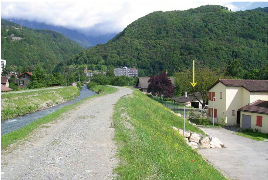
Figure 5-72. Digue du Doménon après travaux - la flèche indique la maison engravée de la Figure 5-73 (Source : R. Tourment).
